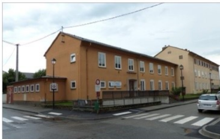
L'école primaire va connaître un important chantier de rénovation d'ici la fin de l'année si toutefois la situation sanitaire l'autorise. Photo L'Alsace]. - M. L.
